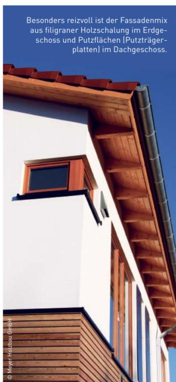
Besonders reizvoll ist der Fassadenmix aus filigraner Holzschalung im Erdgeschoss und Putzflächen (Putzträgerplatten) im Dachgeschoss.
