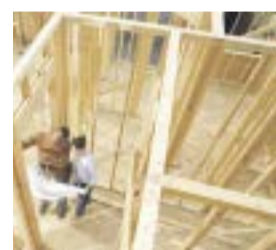
Holzrahmenbau löste um 1900 den Blockhausbau in Kanada ab.
