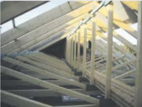
Nagelplattenbinder bieten eine optimale Alternative zum klassischen Flachdach.
