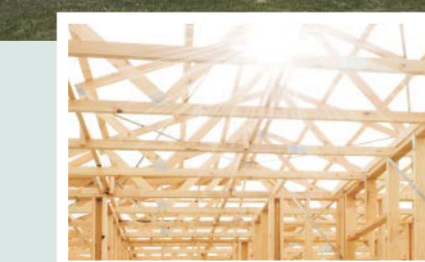
Kurze Bauzeit, termingerechter Einzug – ein Wohnhaus steht in 3 Tagen!
